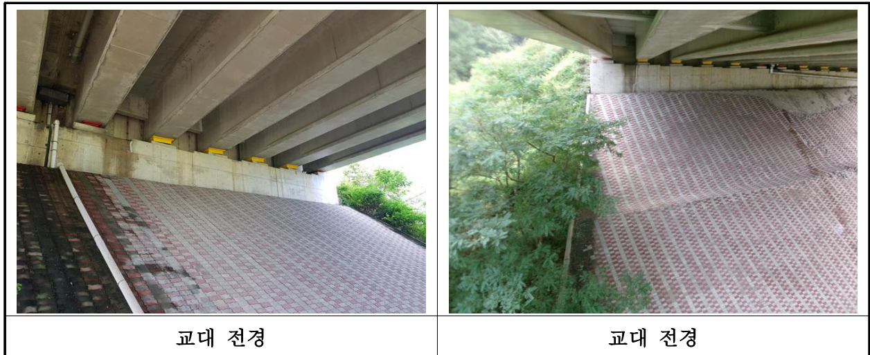
【사진 2.3.8】 교대 전경
