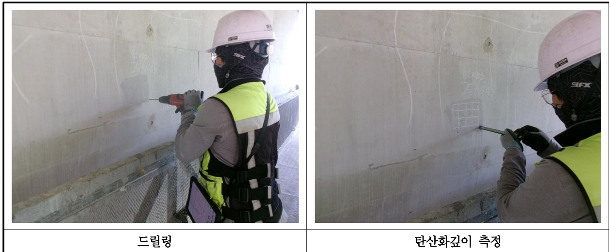
【사진 2.4.3】 탄산화 깊이 측정 현장사진
