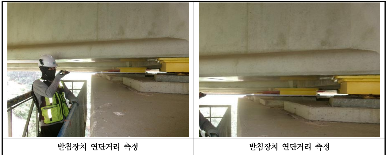
【사진 2.3.15】 교량받침장치 연단거리측정
