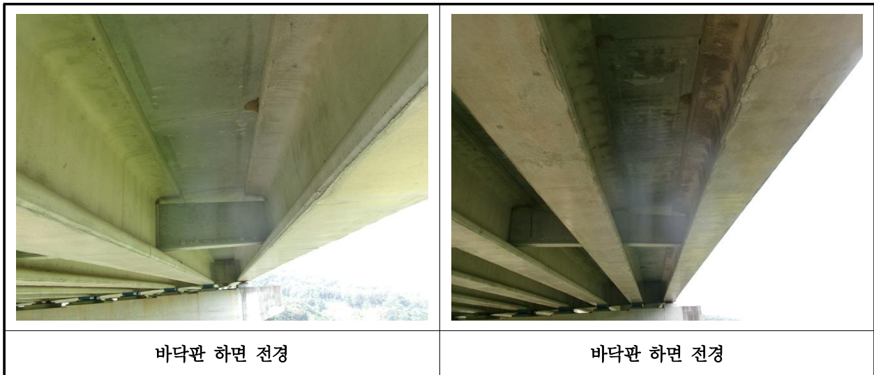
【사진 2.3.2】 바닥판하면 전경
