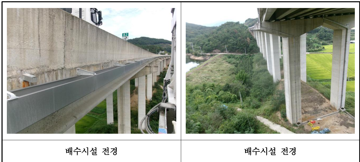
【사진 2.3.49】 배수시설 전경
