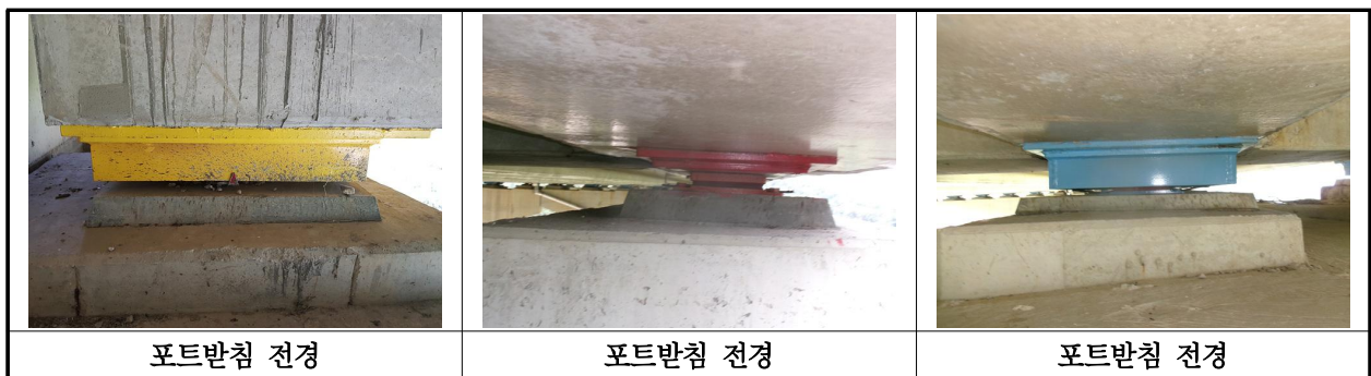
【사진 2.3.13】 교량반침 전경
