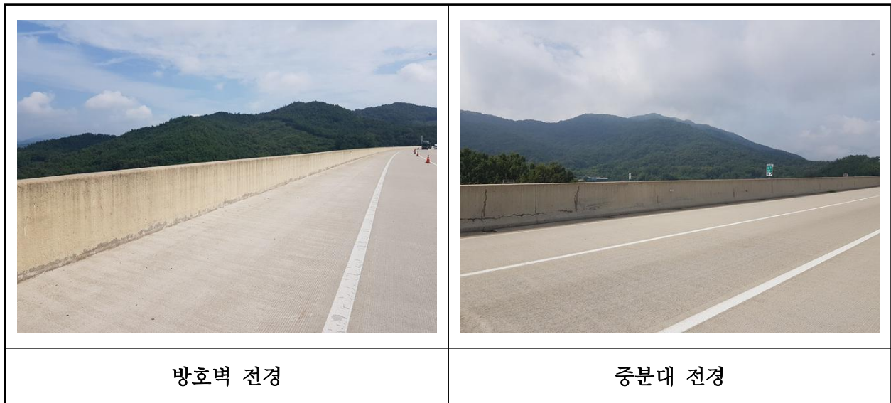
【사진 2.3.24】 방호벽 및 중앙분리대 전경
