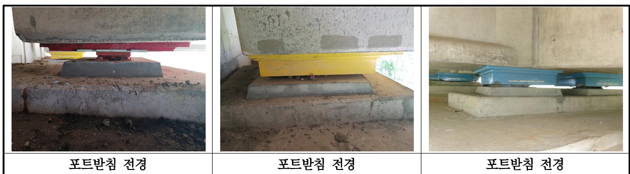
【사진 2.3.40】 교량반침 전경
