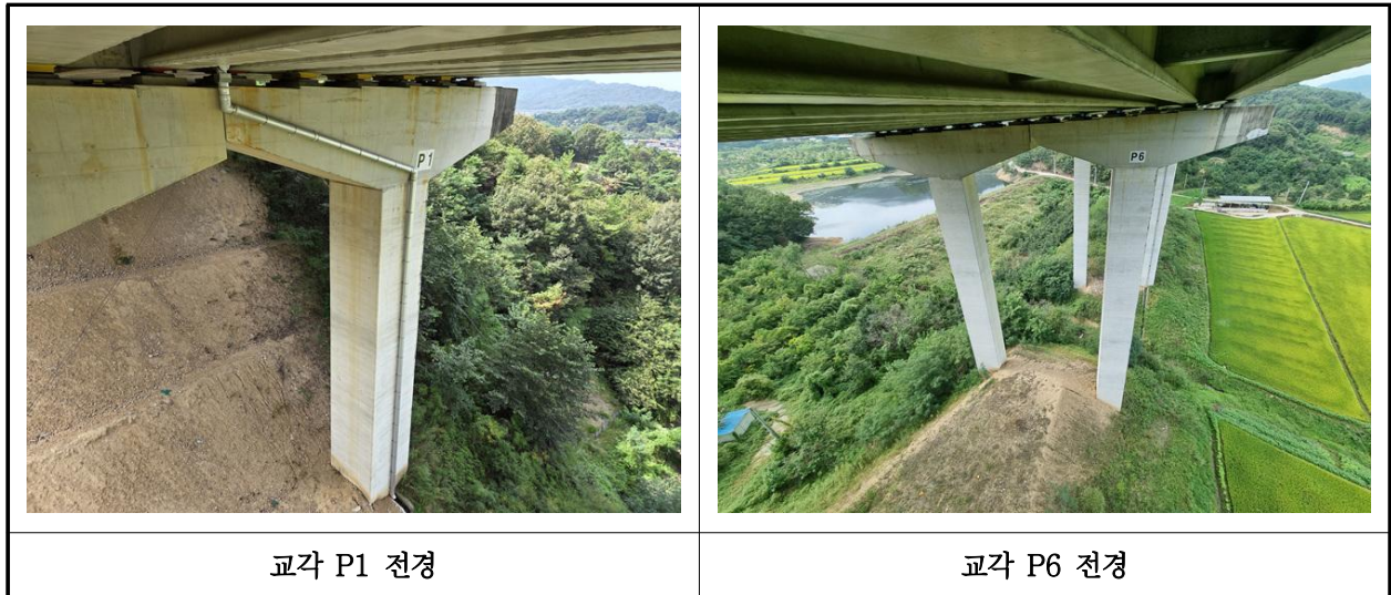
【사진 2.3.10】 교각 전경
