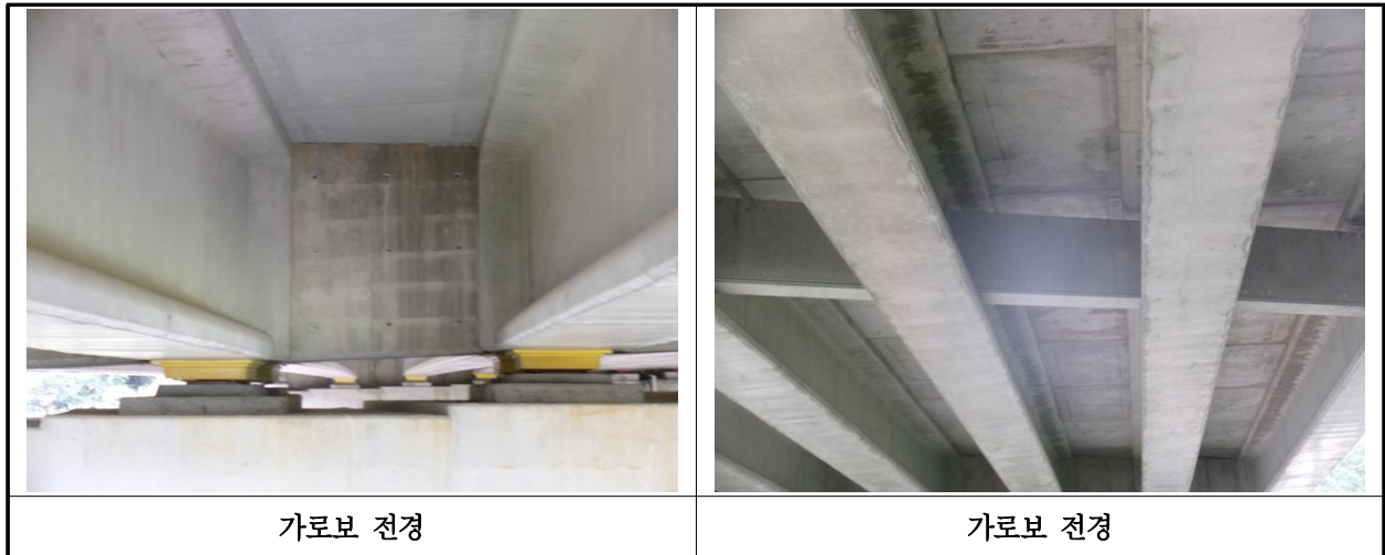
【사진 2.3.33】 가로보 전경
