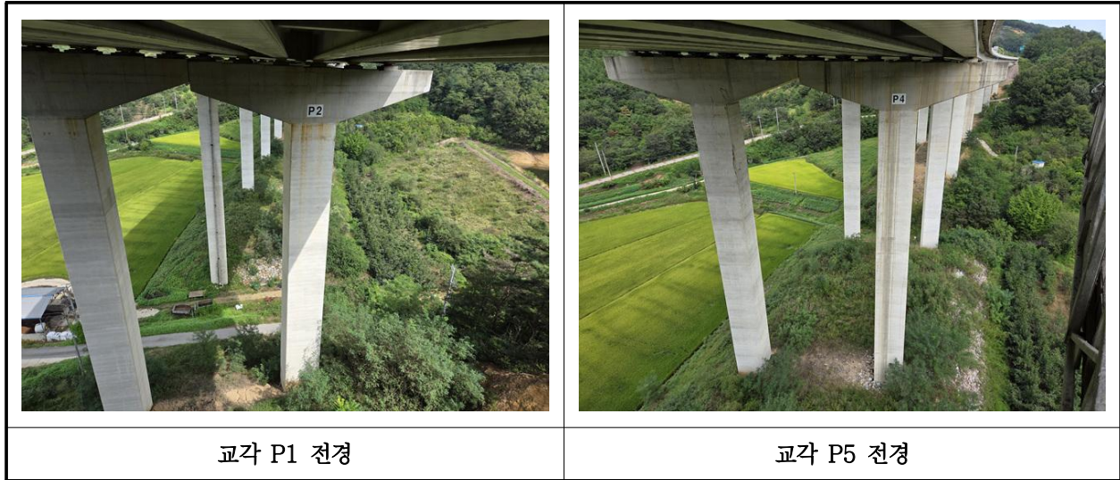
【사진 2.3.37】 교각 전경
