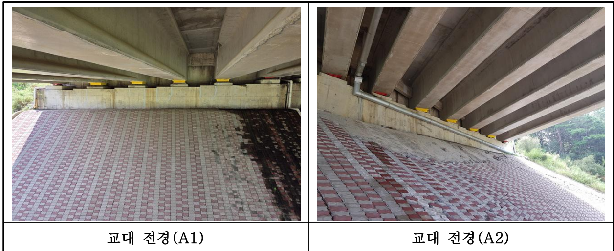
【사진 2.3.35】 교대 전경
