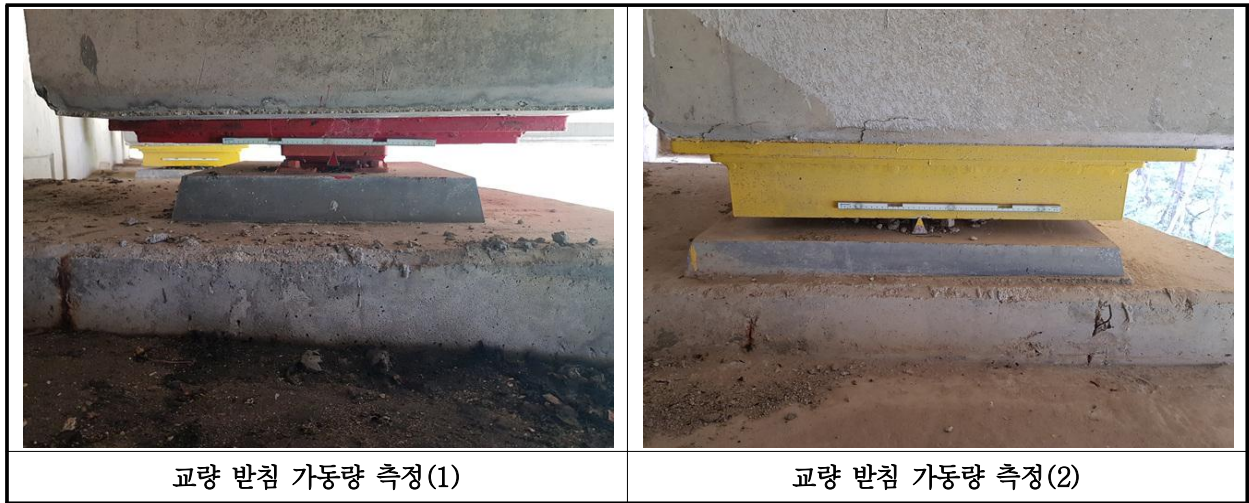
【사진 2.3.43】 교량받침 이동량 측정
