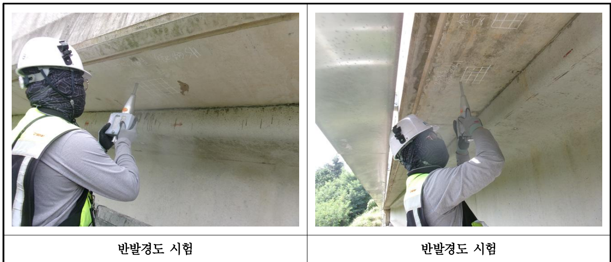
【사진 2.4.2】 반발경도시험 현장사진
